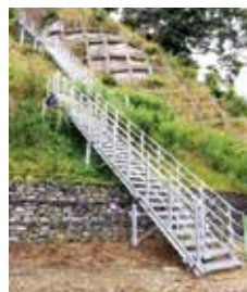
釜石市内の現在の金属製の避難路の様子
