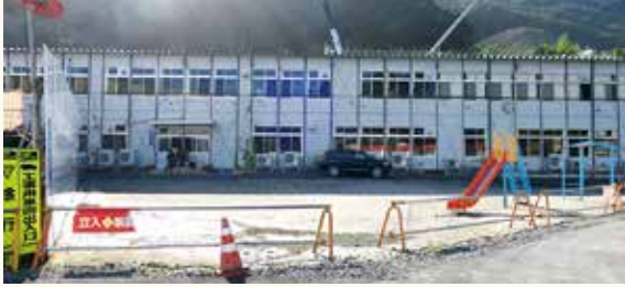
唐丹小学校の校舎と校庭 新校舎を建設中のため重機や工事用の看板が目に入ります。
