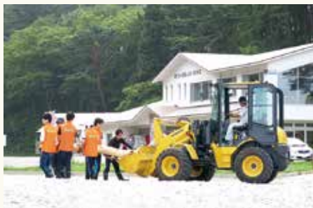
浄土ヶ浜レストハウスの流木撤去作業（宮古市）
