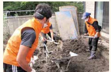
庭先の泥上げ作業②（久慈市）
